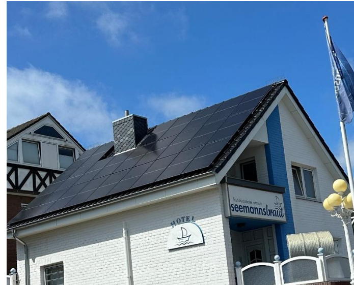
Abb.: Hotel in Wittdün auf Amrum mit PV-Anlage auf dem Dach
